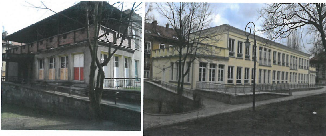
Fot. Stan przed remontem i po remoncie
