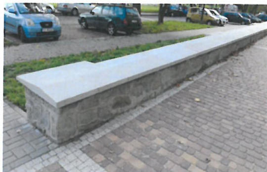
Fot. Stan po remoncie
