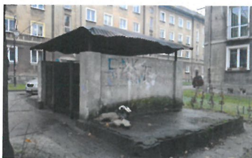
Fot. Stan przed remontem i po remoncie
