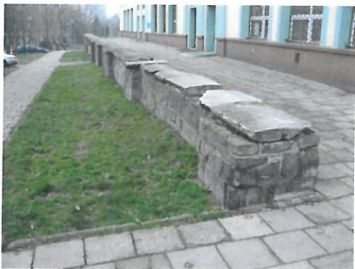
Fot. Stan przed remontem
