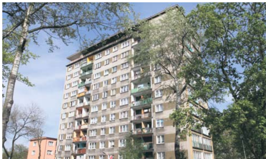
W tym roku kolejne nieruchomości, których współwłaścicielem jest gmina, doczekają się termomodernizacji. Odświeżona zostanie m.in. elewacja bloku przy al. Niepodległości 76-78.
