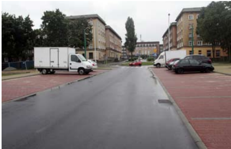
Kilka dni temu oddano do użytku parking przy ul. Andersa, na 60 samochodów osobowych i 3 autobusy.
