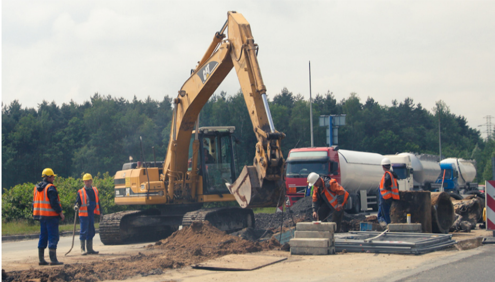
Przy budowie DK1 pracuje 160 osób i 30 ciężkich maszyn budowlanych.
