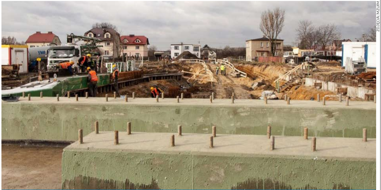
Trwają prace przy budowie tunelu pod DK 1.
