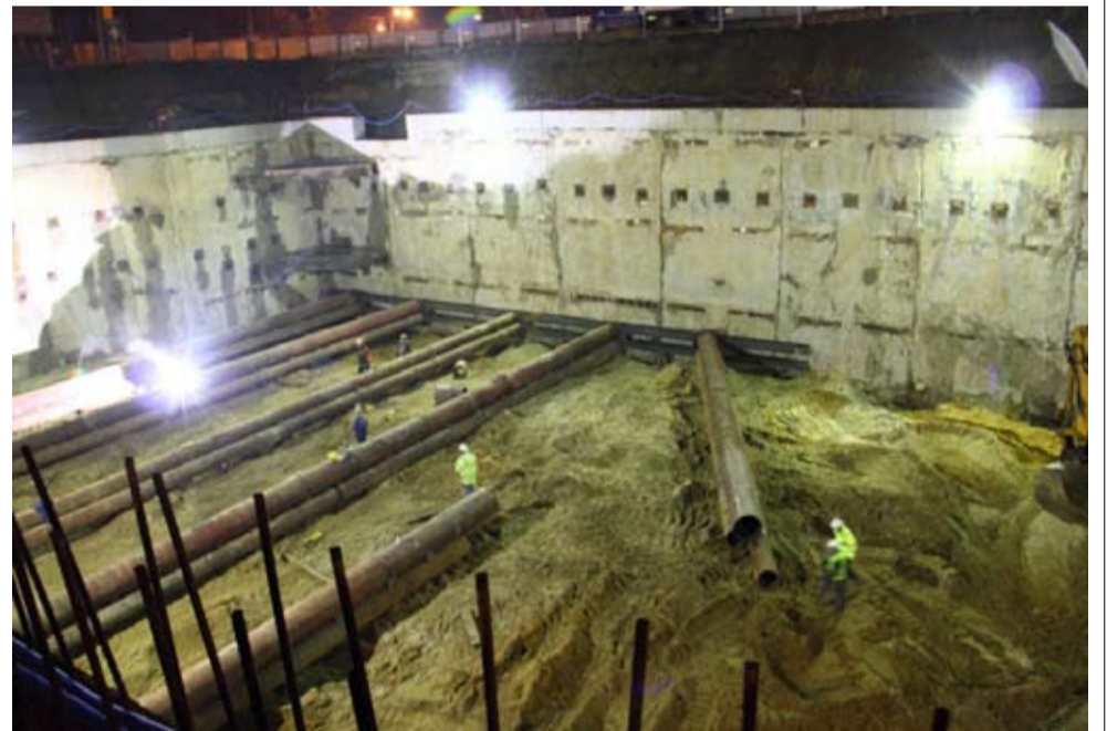
Jedną z większych miejskich inwestycji jest budowa parkingów wielopoziomowych.
