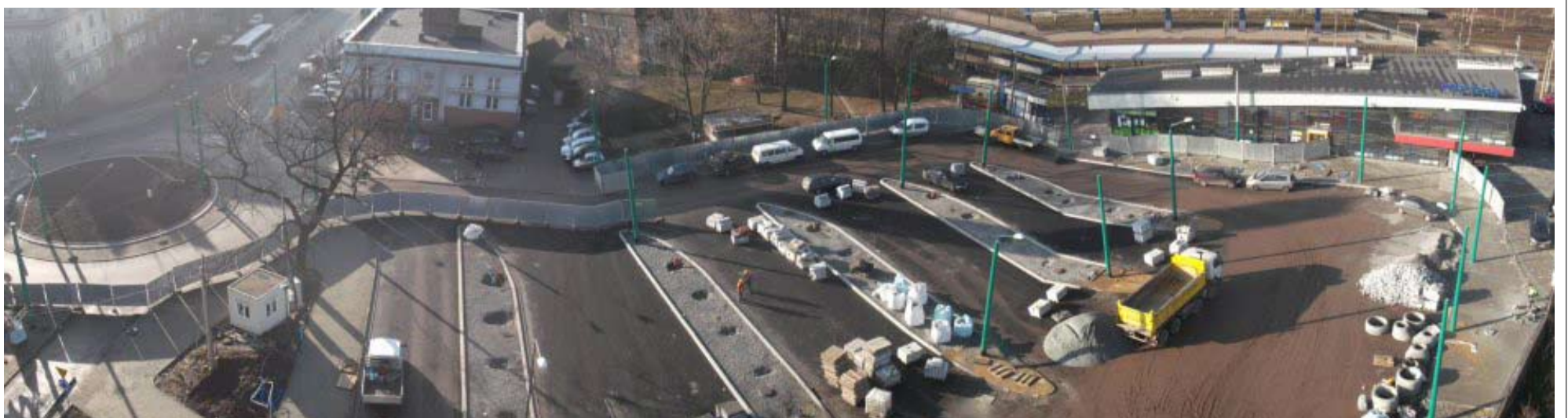
Układ drogowy przy dworcu PKP jest częścią projektu budowy parkingów wielopoziomowych.
