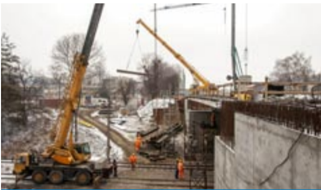
Podczas niskich temperatur prace koncentrują się na obiektach modernizowanego odcinka DK 1.
