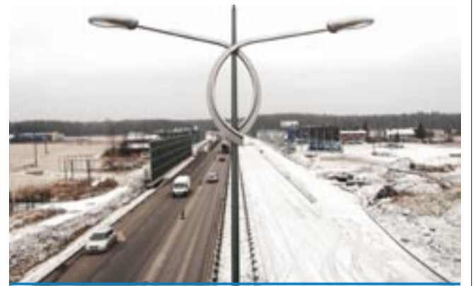
Wzdłuż ulicy Beskidzkiej montowane są nowe latarnie.
