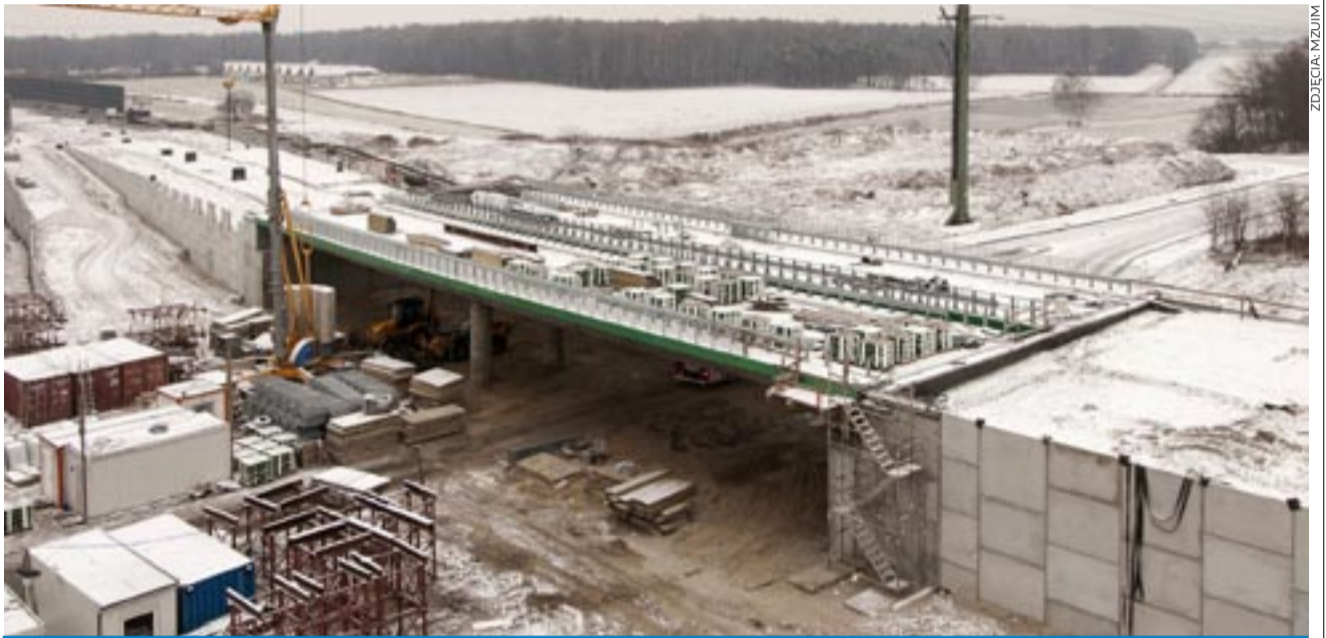
Gotowa jest już w części konstrukcyjnej estakada nad al. Niepodległości.
