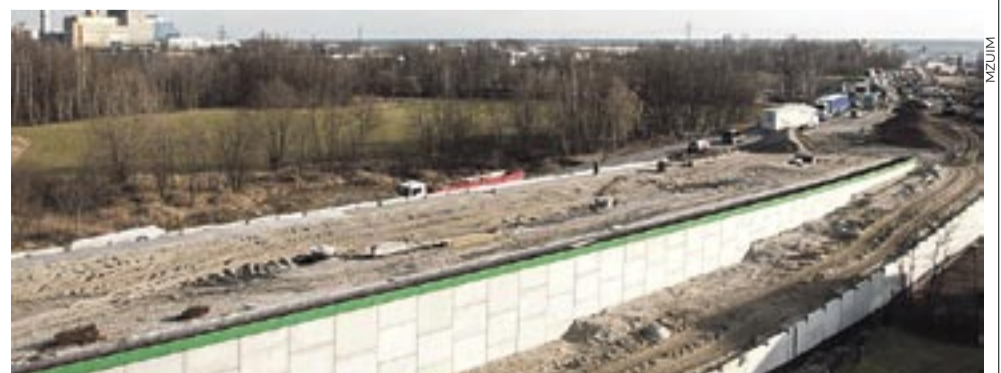
Estakada powstająca w rejonie skrzyżowania ul. Beskidzkiej z al. Niepodległości, rozdzieli ruch lokalny od tranzytowego.
