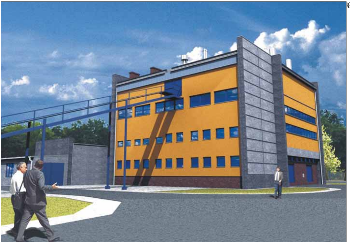
Kotłownia w Wilkowyjach wkrótce będzie gotowa
