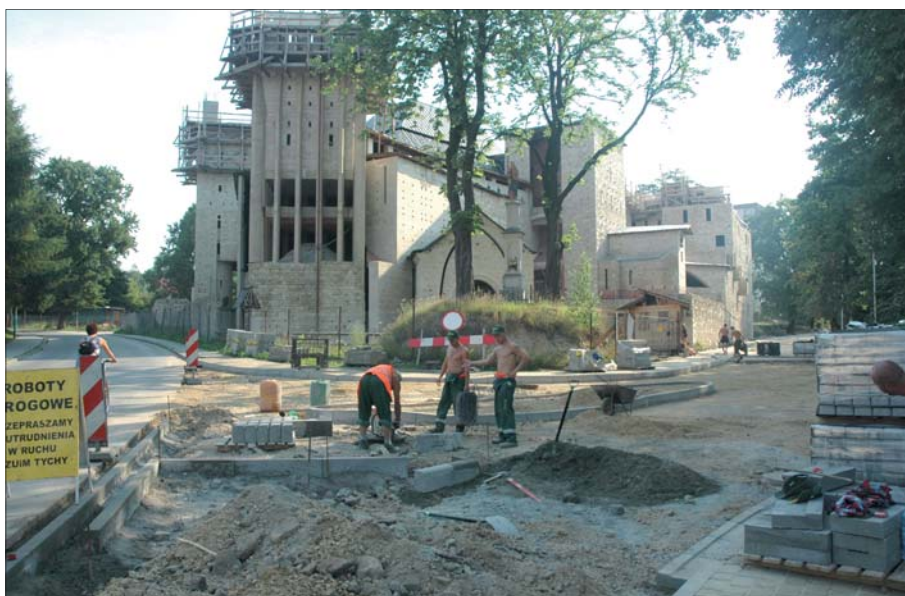
Ulica Przemysłowa będzie gruntownie przebudowana
