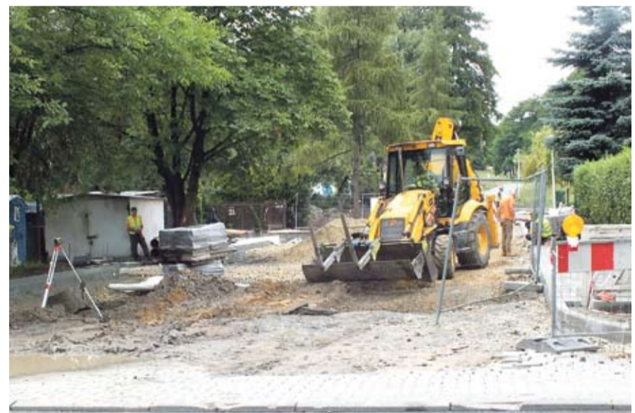
Prace budowlane trwają także przy kościele św. Franciszka i Klary.
