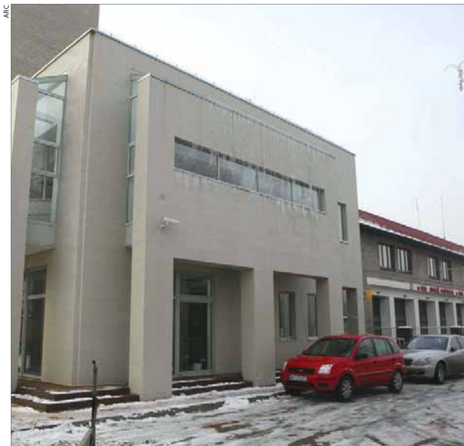
Centrum Zarządzania Kryzysowego jest już prawie gotowe
