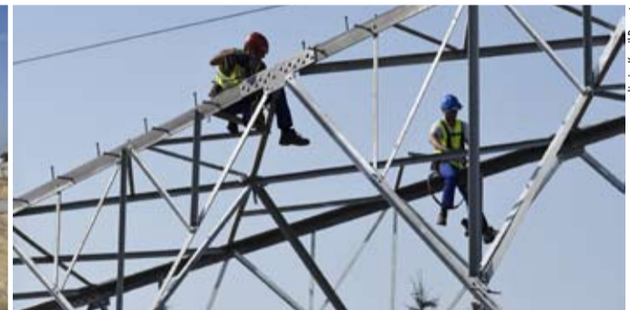
Powstają również nowe maszty wysokiego napięcia, które zastąpią starsze i niższe konstrukcje.
