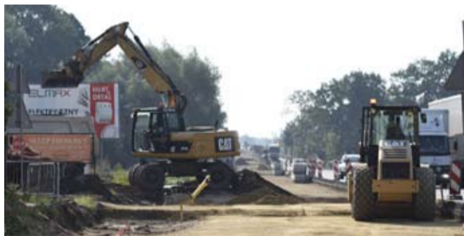
Pomimo ciągłej pracy przy użyciu sprzętu ciężkiego ruch na DK-44 odbywa się obustronnie.
