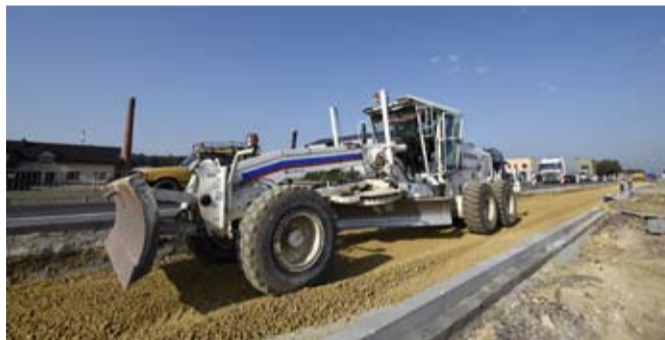
Równiarka profiluje warstwę zamykającą ostatni etap przed asfaltowniem.
