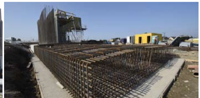
Aktualnie stawiany jest przyczółek wiaduktu, który będzie podpierał koniec skrajego przęsła.
