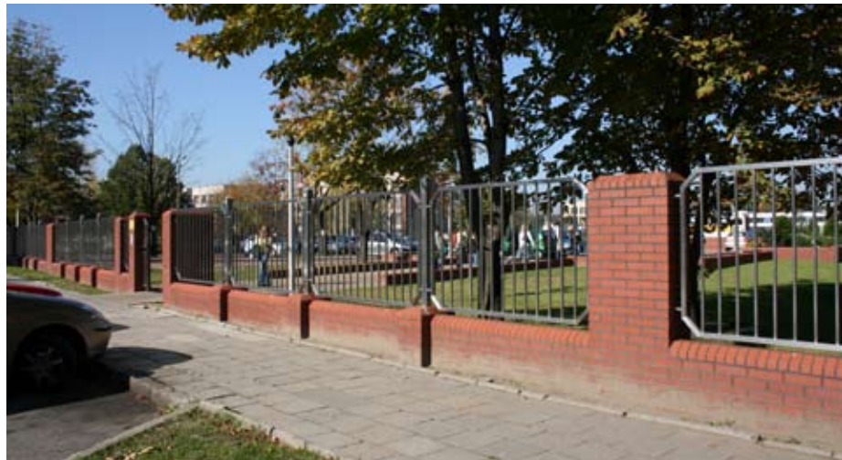
Zmodernizowane ogrodzenie, plac i wejście do budynku Zespołu Szkół nr 1.
